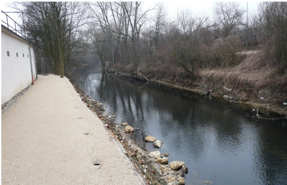
Bild 1: Aktueller Brutplatz des Eisvogels am Steilufer der Fils. Im Vordergrund der bereits fertiggestellte Bauabschnitt mit der „Krainer Wand“
